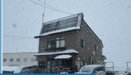
②急斜度屋根設置
